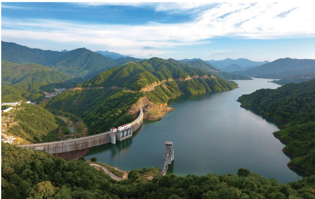
倫潭水利樞紐工程
