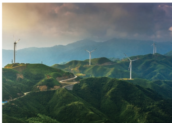
白雲山風力發電站
